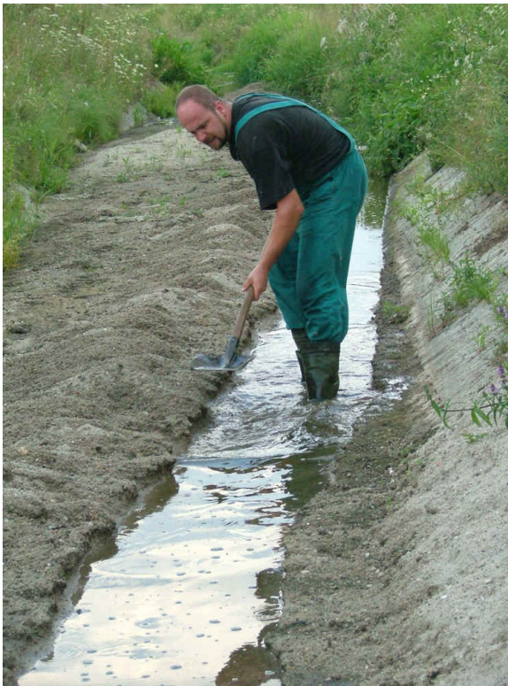
Čištění kanálu (napájení mokřadu) Fotografováno po realizaci 27.7. 2006
