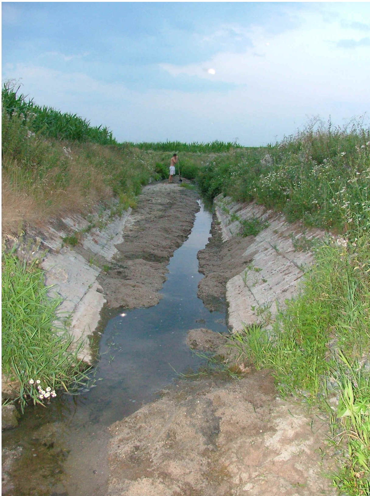
Cca 20 m dlouhý, provizorně vybudovaný kanál, který obnovil průtok zaneseného koryta napájecího mokřad. Fotografováno po realizaci 25.7. 2006
