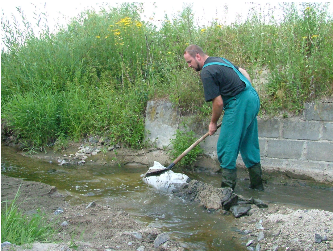
Poslední úprava dělicí hráze, posilnění vodnatosti do mokřadu. Fotografováno po realizaci 27.7. 2006
