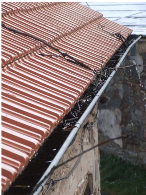
Teplá (KV) – památkově chráněný objekt bývalého pivovaru.
