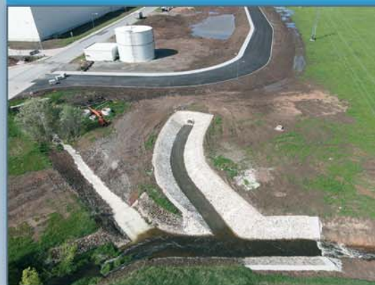
Nově vybudovaná stoka dešťové vody z pozemků a střech průmyslových hal svedená přímo do Lučního potoka, 700m nad ptačí rezervací Nový rybník
