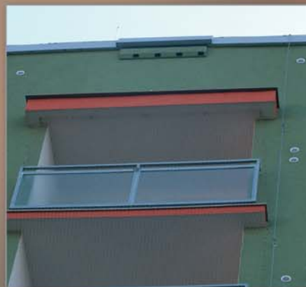
Budky instalované v zateplené fasádě
