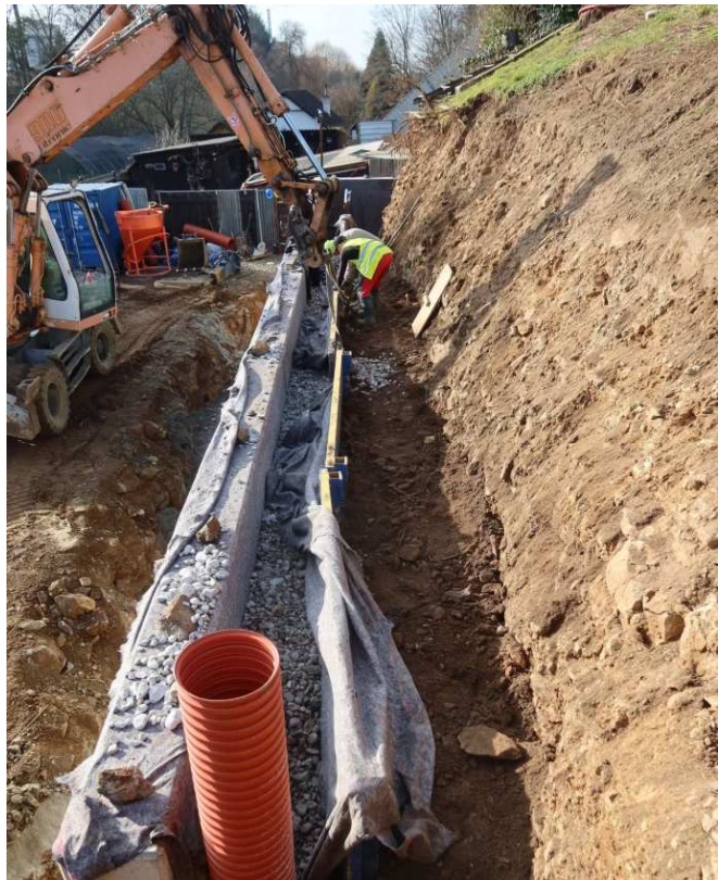
Sanace, izolace rubu zdi opěrné stěny SO11, realizace drenáží a zpětné zásypy.
