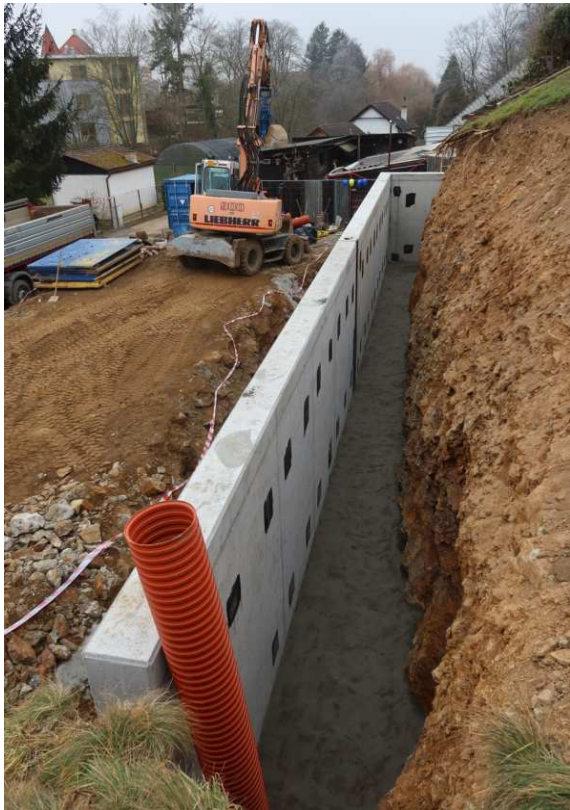
Sanace, izolace rubu zdi opěrné stěny SO11, realizace drenáží a zpětné zásypy.
