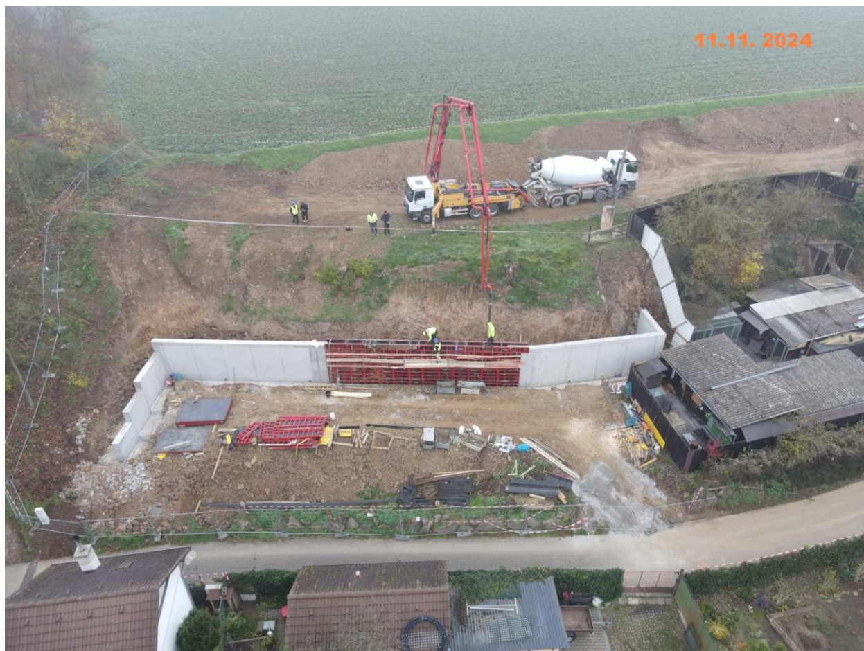
Bednění třetí části první opěrné stěny SO12 a její betonáž.
