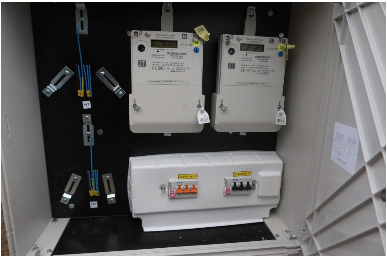
Osazení hlavních jističů a elektroměrů pro budoucí areál ZSŽ. Realizace ČEZ.
